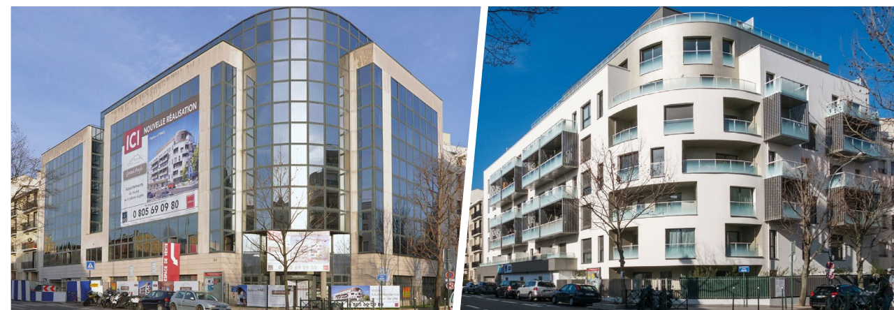
Immeuble de bureaux de 3 296 m 2 transformé en 56 logements et 1 commerce Grand Angle – Asnières – AXE IMMOBILIER
