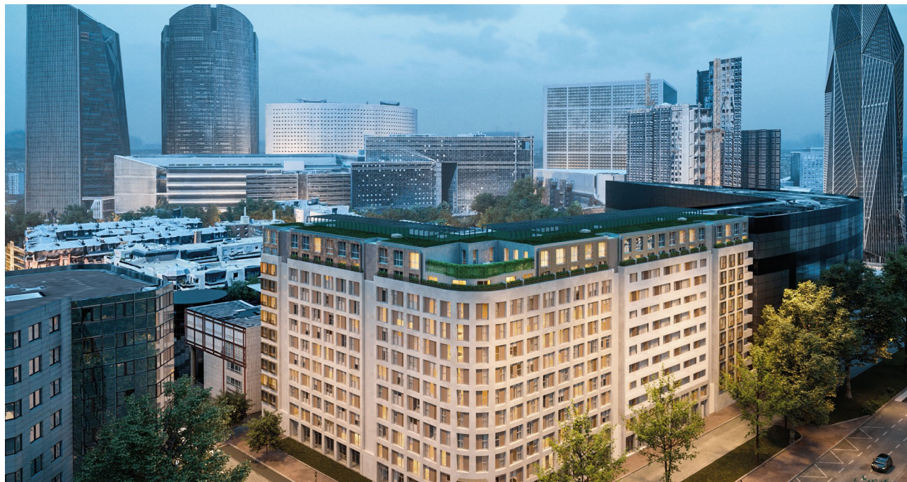
Ancien immeuble de bureaux de 11 000 m 2 transformé en une résidence de 20 732 m 2 pour étudiants et jeunes actifs Lilo – Puteaux – FREQO GROUP
